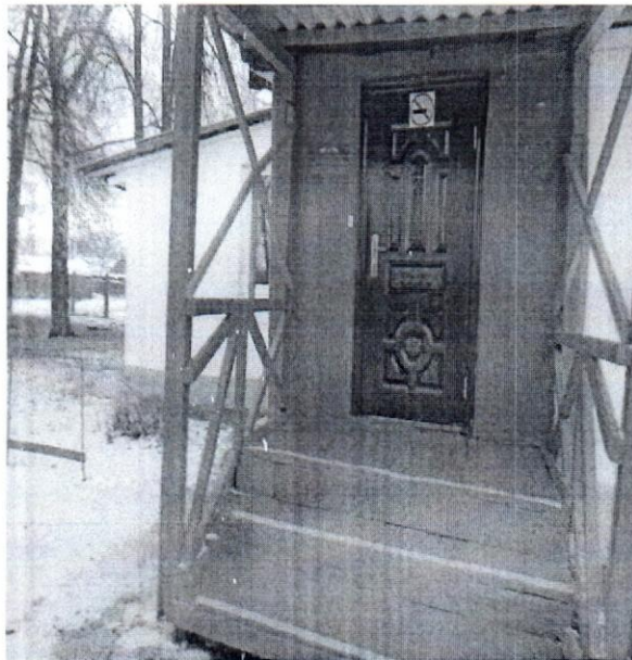
3. Вход в здание
