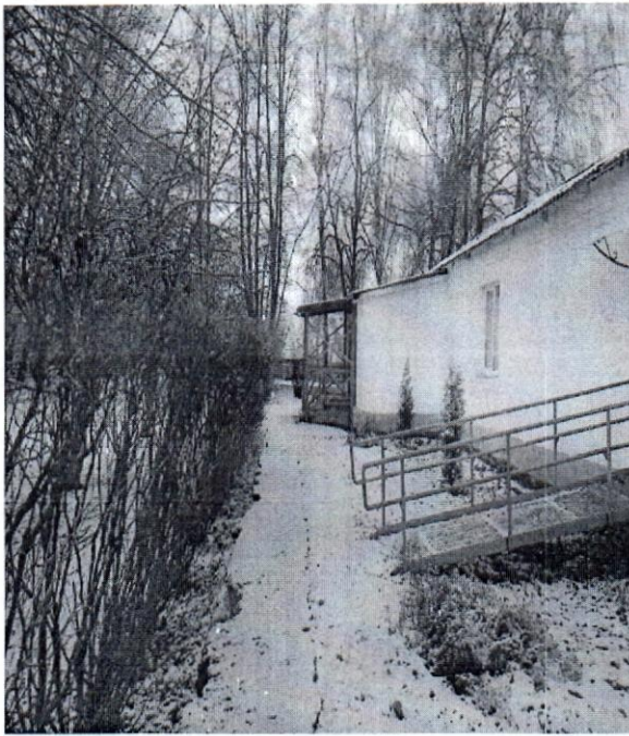
1. Территория, прилегающая к зданию
